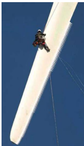
Photographies d'une pale dotée d'un système TES (peigne / dentelure)
